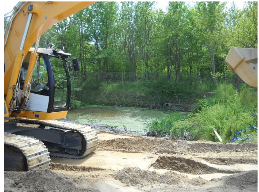
Regnvandsbassin ved Kløvervej i Koldby
